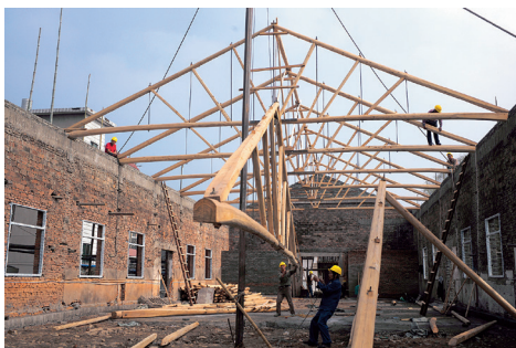
图14: 界首村村落空间重建施工现场
