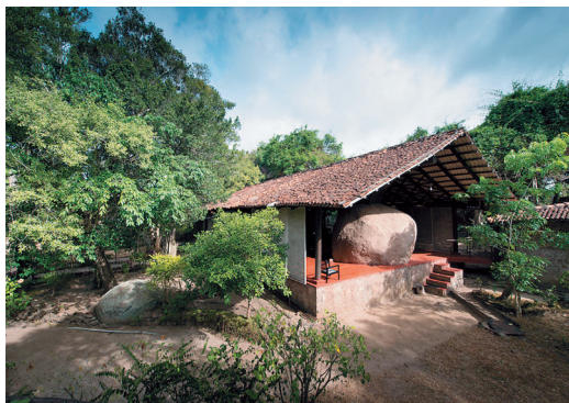
图 28: 波隆塔拉瓦庄园住宅屋顶
