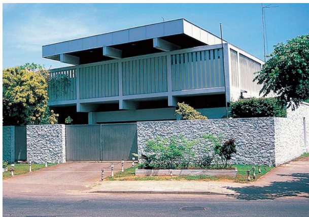
图8：“框架”住宅：贾亚瓦德纳住宅
