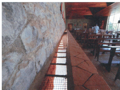
图17: 善导者修道院礼拜堂南墙空隙
