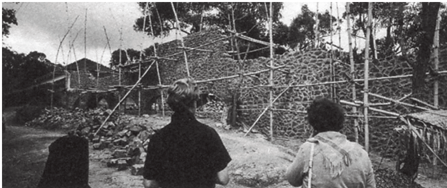
图15: 善导者修道院礼拜堂南墙施工中, 前排中立者为普莱斯纳
