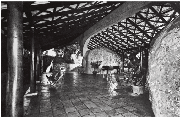
图 26: 波隆塔拉瓦庄园住宅结构梁与原石柱 (营造原始的穴居感)
