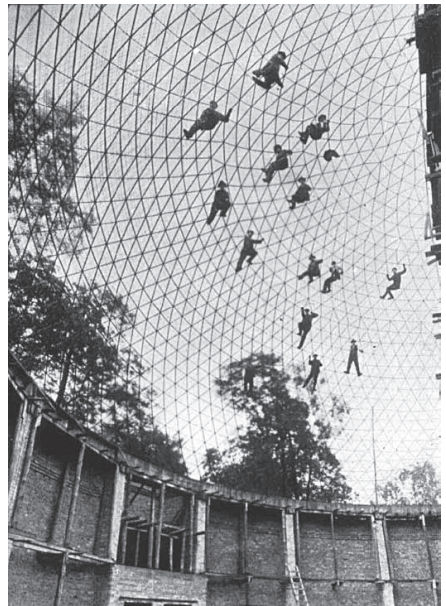
图7：包豪斯的主要成员希尔博赛玛对柏林天文馆施工时的影像记录
