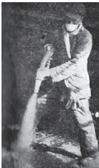
图30：建工局四公司施工喷射混凝土施工现场照片
