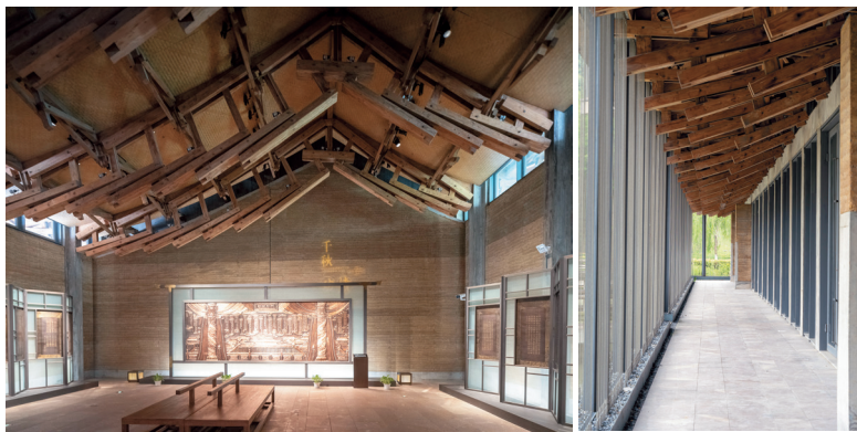
图11: 反曲面屋顶下的细木架构件和出挑。左: 临安博物馆精品厅室内 ® ; 右: 临安博物馆精品厅回廊
