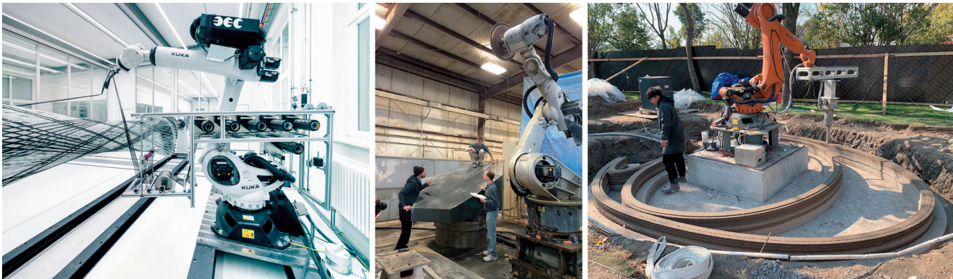
图 1: 由机械臂辅助建造建筑构件
