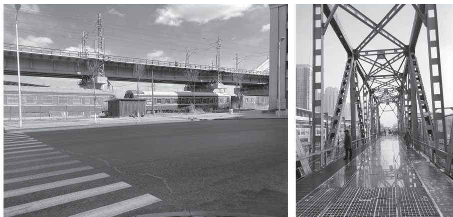
图 12：滨北线废弃路段、滨洲线哈尔滨松花江大桥
