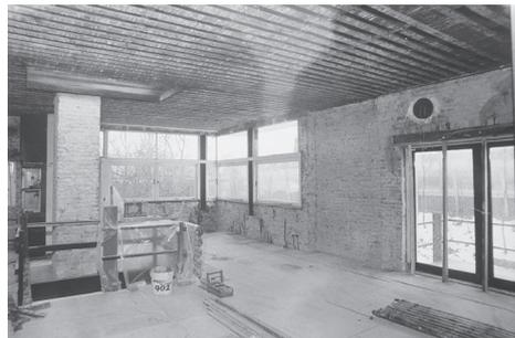
图 16: 室内墙壁和天花板被拆除表面后的样子
