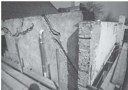
图 14: 墙面上有很深的裂痕
