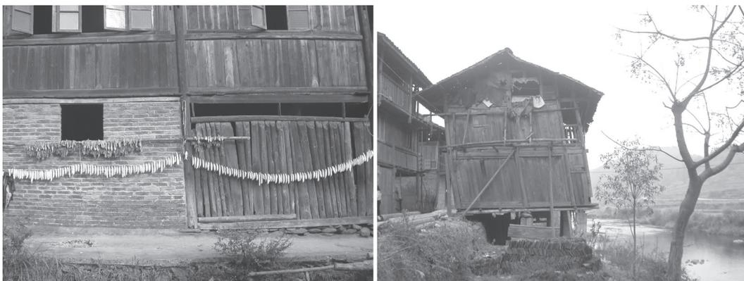
图11：中国传统穿斗木架缺乏非正交构件导致木框架易于变形、失稳和引起结构破坏
