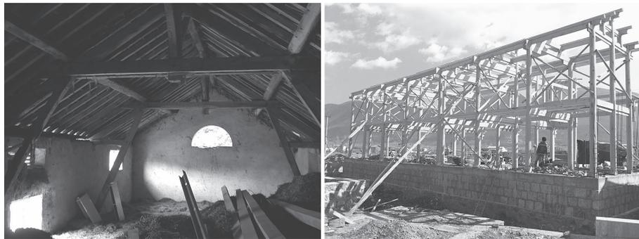
图12：法国Château de Digoine古堡始建于1233年(左)，利用三角形稳定性原理设置桁架与角撑，而2014年初建于中国云南大理的民居穿斗木架(右)仅将剪刀撑和斜撑作为施工临时支撑构件来使用
