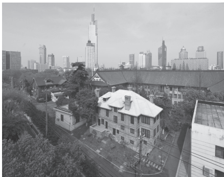
图 13：南京大学赛珍珠故居，修缮后的整体外观形象，2012 年
