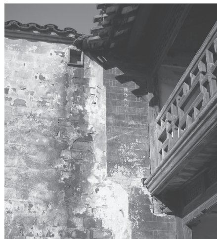
图8：蒋寿山故居修缮前，楼座檐口山墙处的壁龛，2010年
