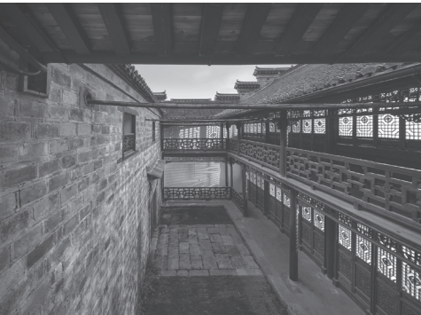
图9：蒋寿山故居修缮后，保留并修复的内排水系统，2018年
