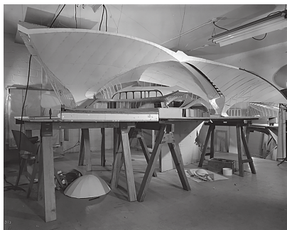
图11: 环球航空公司候机楼屋顶模型
