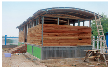
图4：郝堂村物件化实践——郝堂村茶室(上)、风雨桥(中)、小学生态厕所(下)
