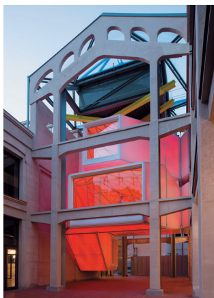
图3: 普拉多媒体实验室，马德里普拉多 (Prado)，马德里。Langarata-Navarro 在建筑的表面置入了新的设施，以便将位于城市中心的一个老锯木厂建造为媒体实验室
