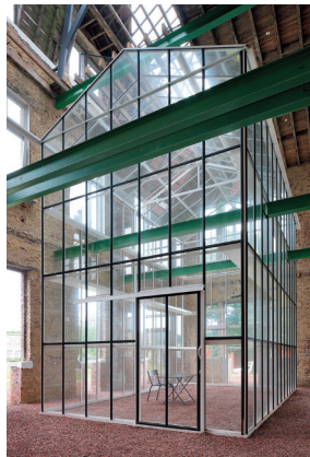
图17: 精神病学大楼改造项目的玻璃盒子(比利时, 梅勒, 2015~2016年)
