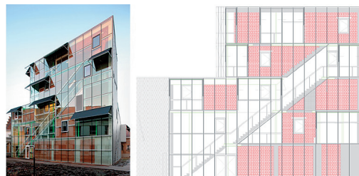
图 9: Les Ballets C de la B 办公楼立面建成效果(左)与建筑绘图(右)的对比(比利时, 根特, 2005—2008 年)
