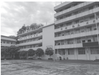
图6：本部大礼堂原址现状
