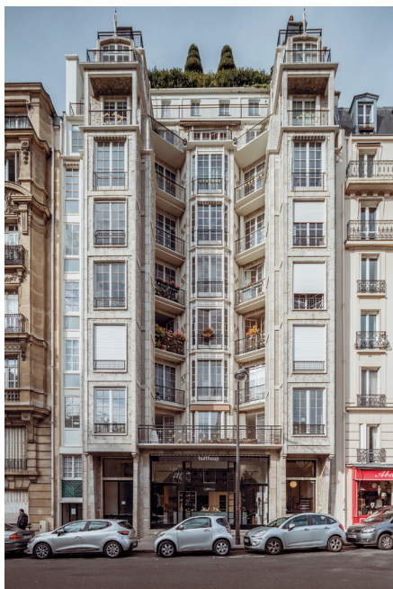
图1：富兰克林路（Rue Franklin）城市住宅，奥古斯特·佩雷（Auguste Perret），巴黎，1903—1904年
