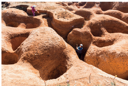
图 26. 挖掘土地作为混凝土模具
