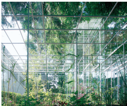
图8：极致的自然项目中，玻璃辅助极细钢柱增强稳定性
