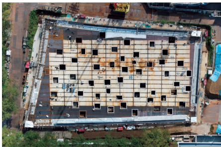
图 23：KAIT PLAZA 施工现场——拼接屋顶
