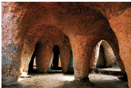
图 25. house &amp; restaurant 施工阶段——拆除模板后
