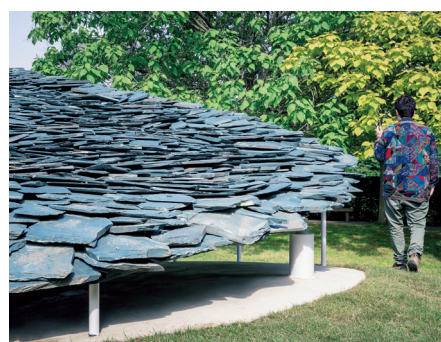
图 12: 蛇形画廊边角位置柱子加粗
