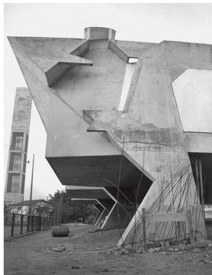
图3：安亨比网球俱乐部支撑结构上的排水口
