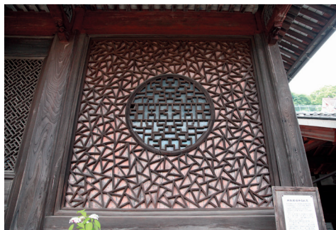
图27: 兴福寺大雄宝殿冰裂纹窗户
