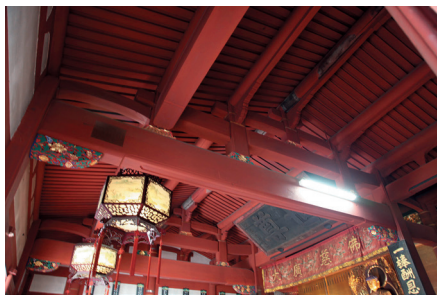
图 33: 崇福寺大雄宝殿室内穿斗梁架
