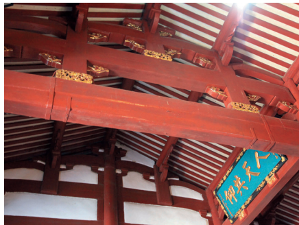
图41：福建福州明代石松寺古殿穿斗梁架
