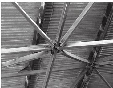
图 20: 桁架结构的关节
