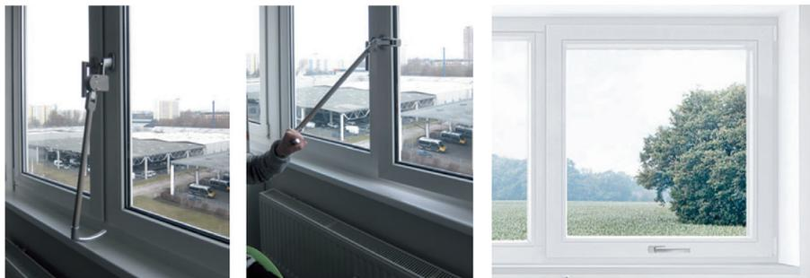
图 14: 左, 加长的杠杆帮助开窗; 右, 安装在窗扇下部的窗把手
