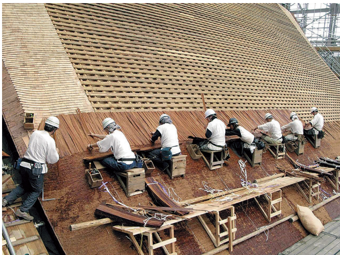
图4: 柏树皮屋顶上的日本传统建筑工艺, 被列入联合国教科文组织的非物质文化遗产名录
