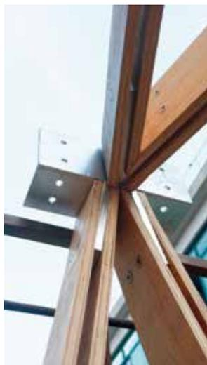
图11: 素然连廊——钢件与木构件的连接, 多相工作室(2014年)
