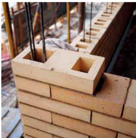
图20：“楷林汇”耐火砖砌块构造，多相工作室（2013年）
