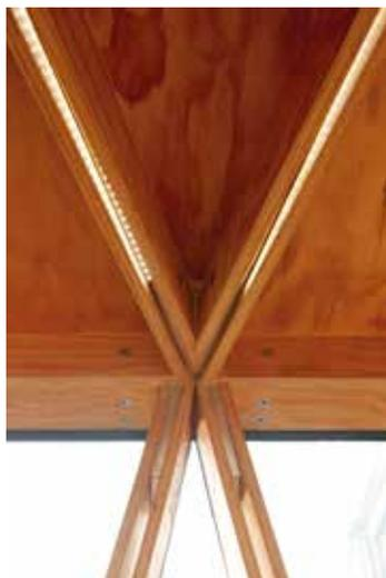
图12: 素然连廊——木板之间的缝隙, 多相工作室(2014年)
