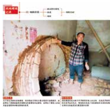
图21：建构课作业——努比亚拱建造实验（2021年）
