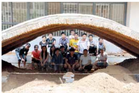
图20：建构课作业——双曲拱建造实验（2013年）
