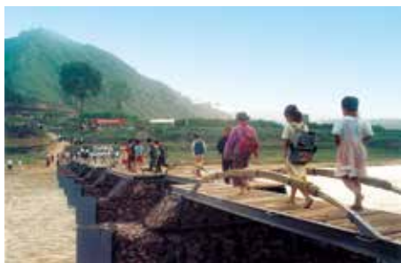
图13: 完成后的毛寺村无止桥
