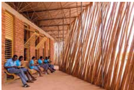
图4: Lycée Schorge 中学, 屋顶和木棍形成的阴凉, 冷空气通过座椅下方的通风口进入室内, 形成对流
