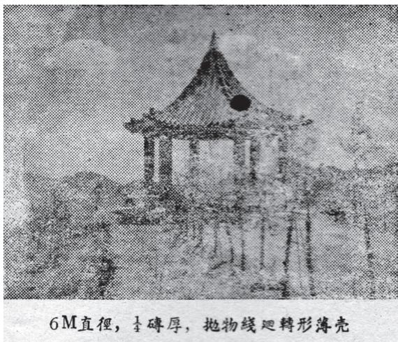
6M 直径， $\frac{1}{2}$  砖厚，抛物线回旋形薄壳
