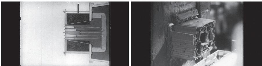
图6a: 在科教片《拱壳砖》中显示的空心“挂钩砖”的模具和挤出工艺截图
