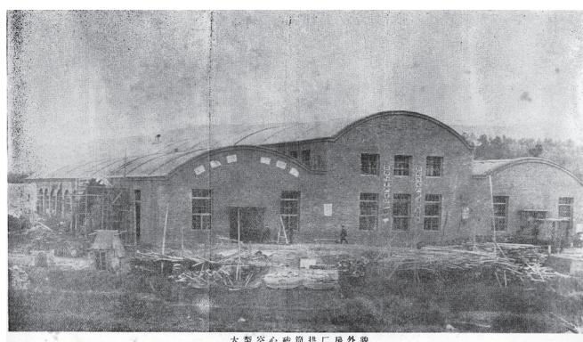
图 3a: 大型空心砖筒拱厂房的实景照片
