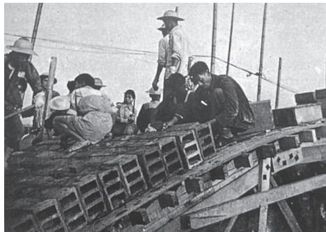
图 4b: 学生在砌筑大型三孔空心砌块
