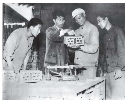
图6b. 南京新宁砖瓦厂工人、技术人员与管理者“三结合”进行研发拱壳砖的照片
