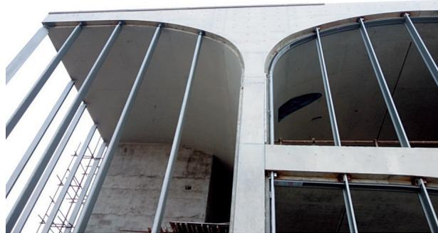
图7: 龙美术馆弧形现浇混凝土
