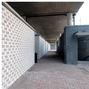
图 14: 西村大院墙体和地面使用的再生砖
