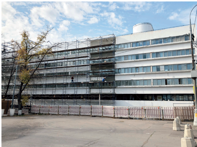
图 26：正在修缮中的莫斯科纳科芬公寓大楼
