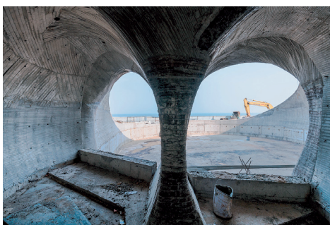
图4: 沙丘美术馆混凝土模板的“书法书写”
