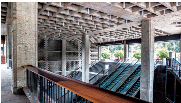
图 10: 西村大院现浇混凝土
