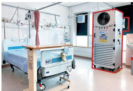
图4: HEPA装置与负压居室改造
