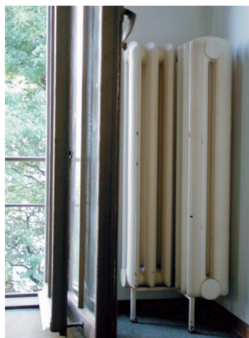
图 15: 定制的角度散热器由两部分组成
