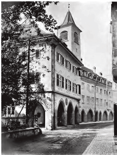
图 18: 哈尔邮政大楼主要道路——克里普路视角
