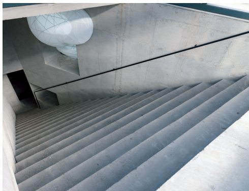
图 7: 从屋顶俯瞰大楼梯
