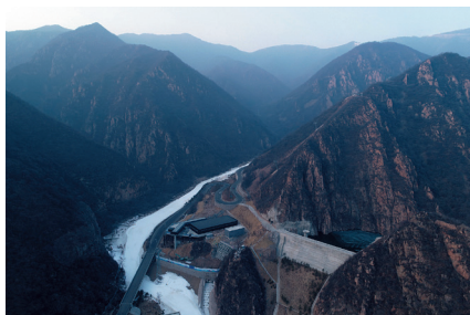
图 4：基础设施“山林”（从左到右依次为：A1、A2 索道中站，1 号生活泵房，1050M 塘坝）
