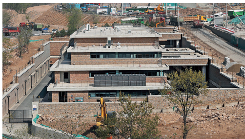
图 5：“融入地景”的海坨变电站
