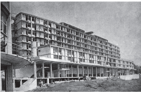
图7：克莱威夫卫生城酒店建造工地现场
