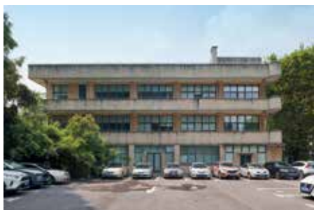
图12：南京招商局办公楼。设计/建成：1947年/1947年；建造地点：南京市下关区江边路24号；朱昊昊分析
