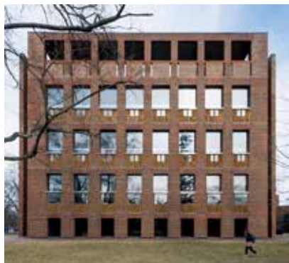
图 16: 埃克塞特图书馆砖砌承重墙收分
