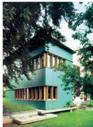
图2: 东南角外部照片
