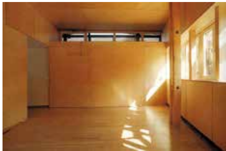
图 23：“胶合板住宅”的室内照片，右侧可见其结构与窗户的分离关系
