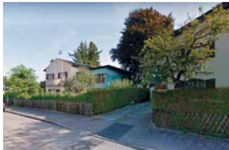
图 24：谷歌街景中的加建住宅现状
