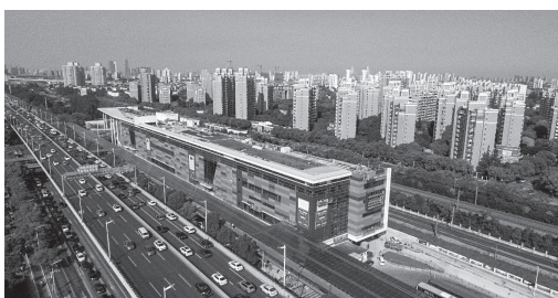
图7：莲花路lalastation建成照片
