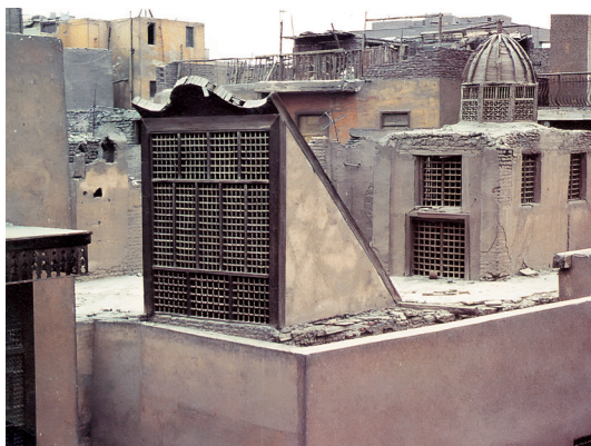
图8：开罗建筑屋顶上的 Malqaf
