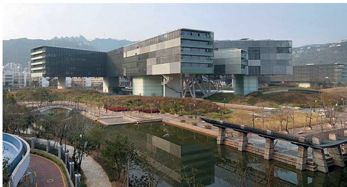
图 13: 深圳万科中心底层架空
