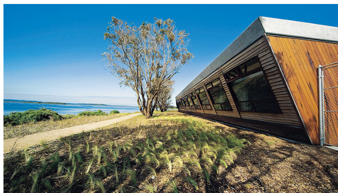
图4：某临湖建筑面向湖面的前倾立面
