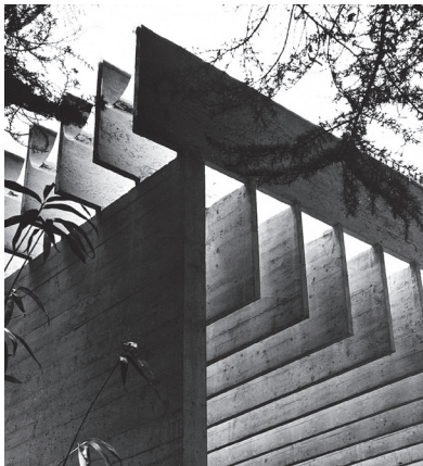
图 14: 上下正交叠置的薄板状混凝土梁
