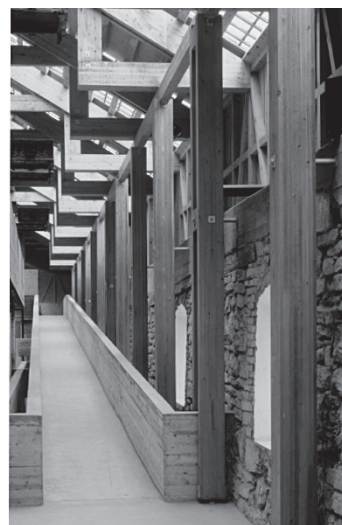
图 24：木构架置于遗迹和混凝土平台之上
