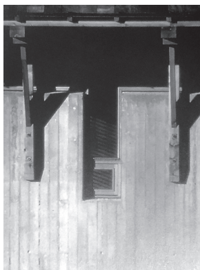
图 29：木构屋顶与混凝土墙体的连接
