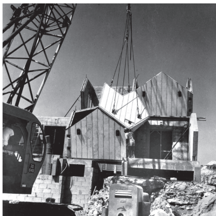
a) 住宅模块组装过程
