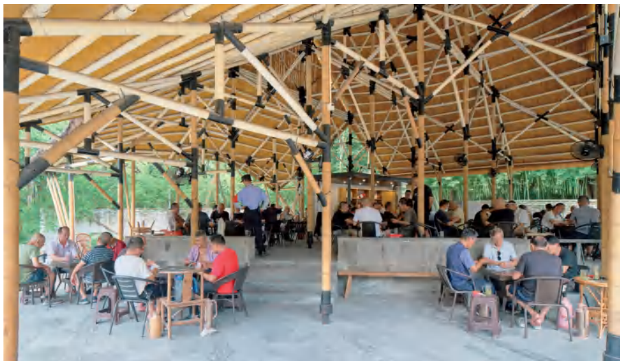
图 30：2023 年何陋轩保护修缮后的竹桁架，图 29 即在此图基础上绘制，2024 年摄
