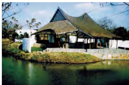
图21：何陋轩1987年建成后的刷色效果，桁条、斜撑均刷白色，冯纪忠拍摄，年代不详
