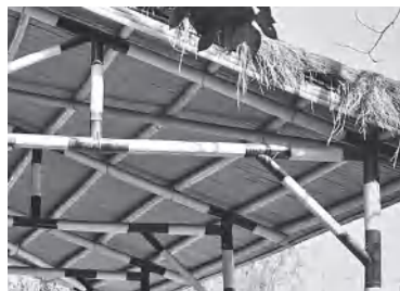
图 3: 经松江区园林局组织的 5 次修缮后(未经冯过目)的何陋轩插接节点照片,2012 年摄
