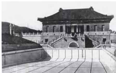
图 17: 南京中央体育场旧址游泳池新旧对比
